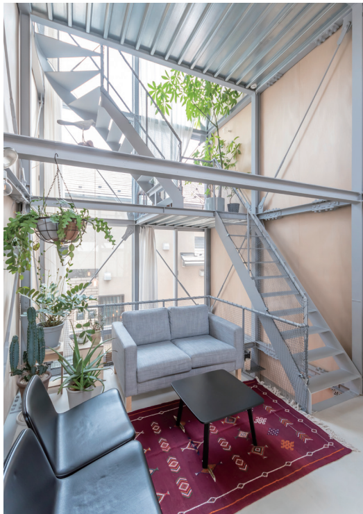
階高は2.2m。この場所は2層分あり狭さを感じさせない。鉄骨なので将来の増床も可能だ。
